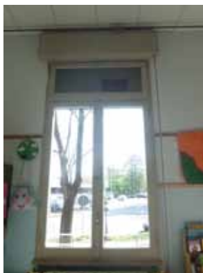
I vecchi infissi
